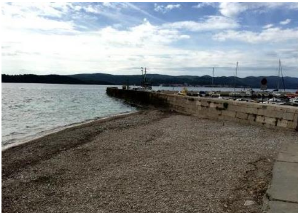
Slika 3.1.-3.: Šljunčana plaža na vanjskoj strani lukobrana i postojeći izgled parapetnog zida
